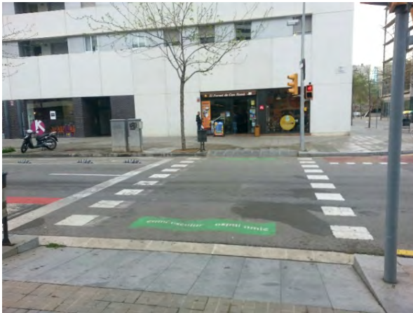
Pas vianants c. Pujades/ c. Fluvià (Besòs)
