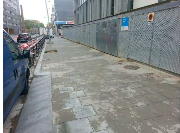
Entrada escola c. Pujades
