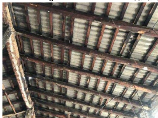
Restauració d'estructura de fusta original i nova coberta complint "CTE"
