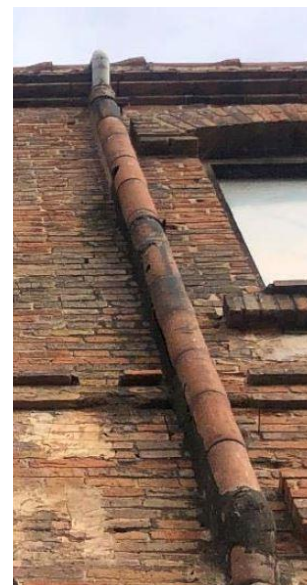
Reconstrucció de ràfec de coberta de 3 maons ceràmics, canal de ceràmica i baixants ceràmics originals
