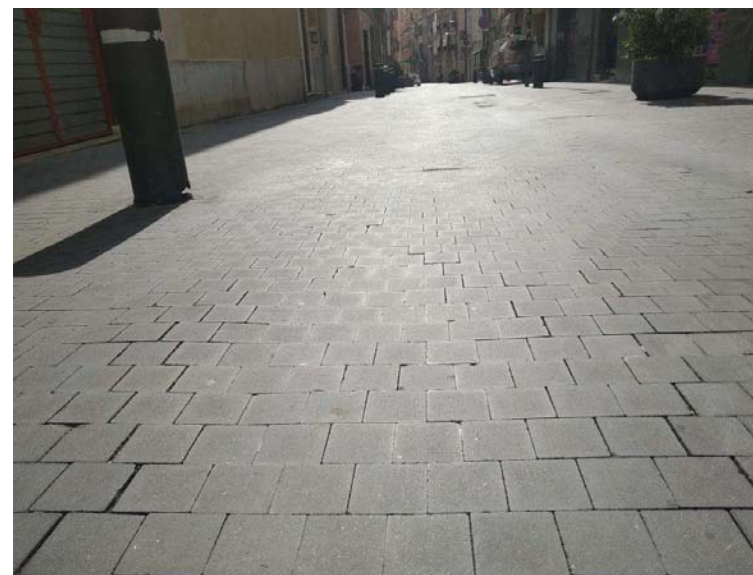
Paviments Carrer Rossend Arús
