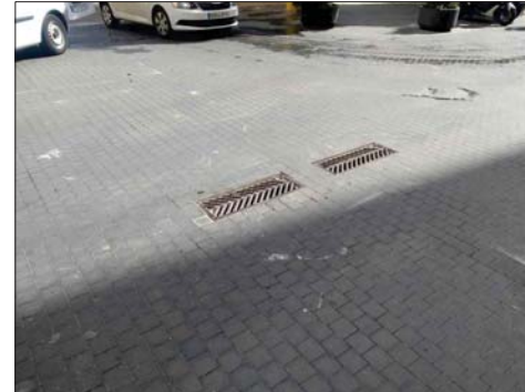
Fotografia 2: Vista embornals cruïlla carrer Ferreria
