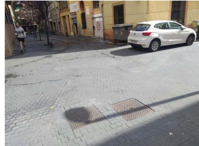
Fotografia 6: Paviment peces 10x10x10cm en mal estat en cruïlla amb Maria Victòria
