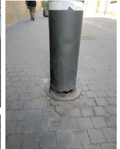
Fotografia 5: Vista pilona a reposar
