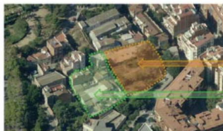
Vista aèria 2010 (abans dels enderrocaments de la Fase 2)
