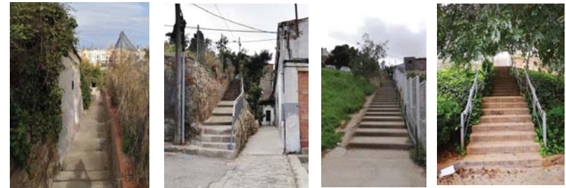
Escales del carrer de la Begònia.
