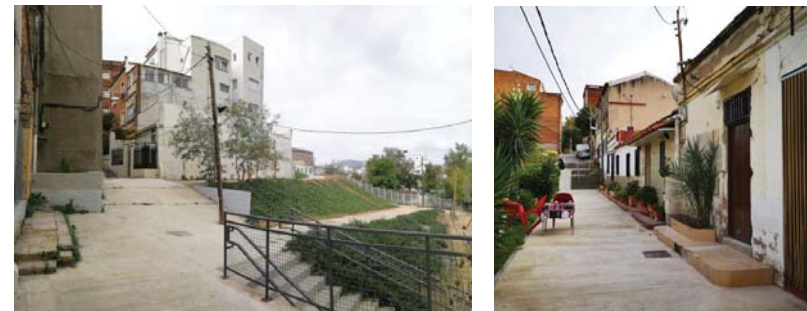
Escales del carrer de la Hortència i rampe de Pas de Valls.
