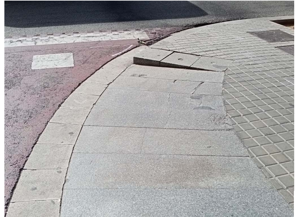
Fotografia 2: Reconnstrucció del pas per alineació de capçal i renovació de peces trencades
