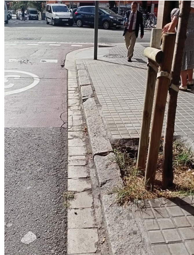
Fotografia 6: Tram de vorera i rigola a renovar per el mas estat es que es troben
