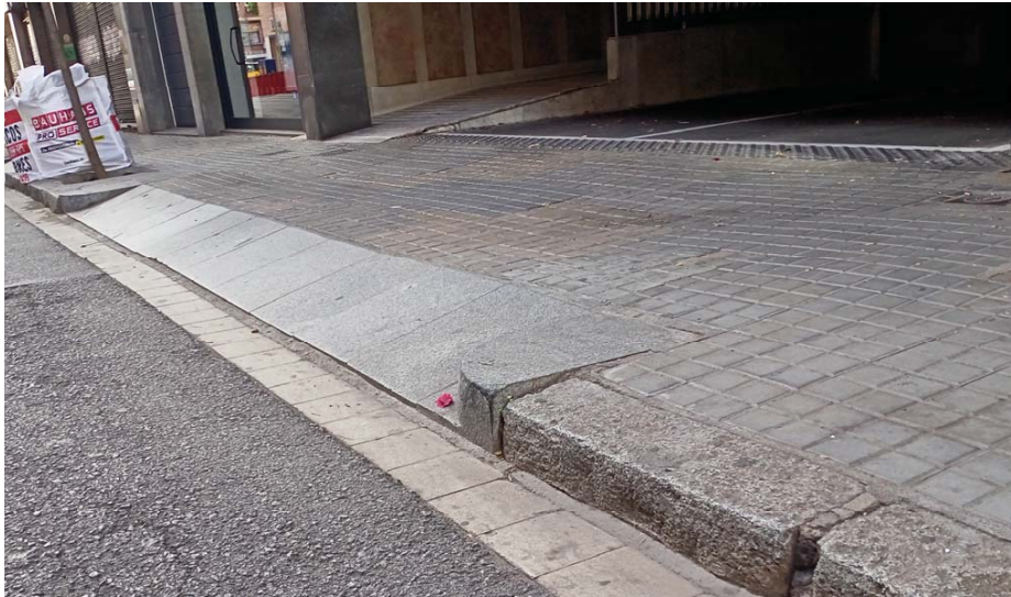
Fotografia 5: Tram de vorera a reposar amb peces de panot de 8 cm gruix per a pas de vehicles
