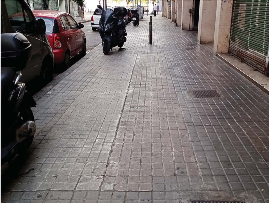
Fotografia 3: Vista general de la vorera a substituir
