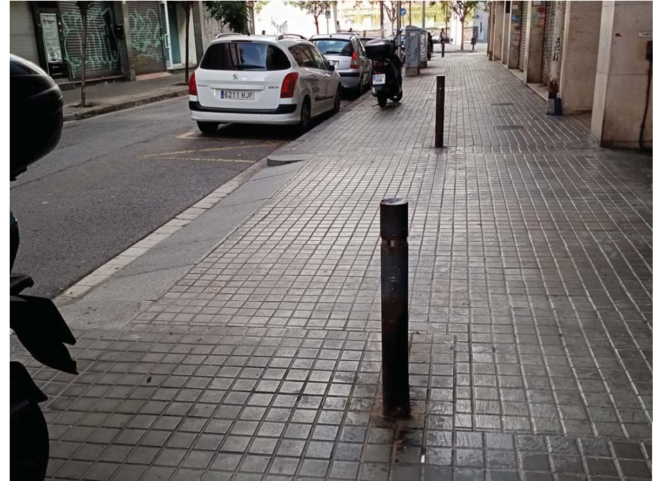
Fotografia 4: Pilonos a l'entrada de vehicles al pàrquing a recol·locar
