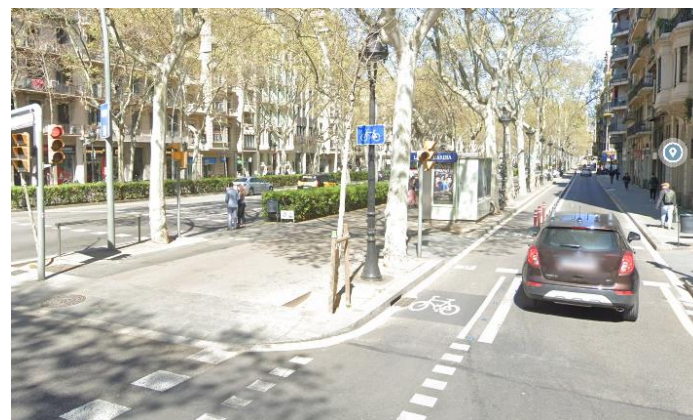
Gran Via. Doble carril bus, carril bici en calçada, laterals 30
