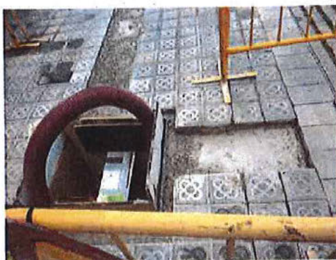
Imatge 9: Execució d'una arqueta
