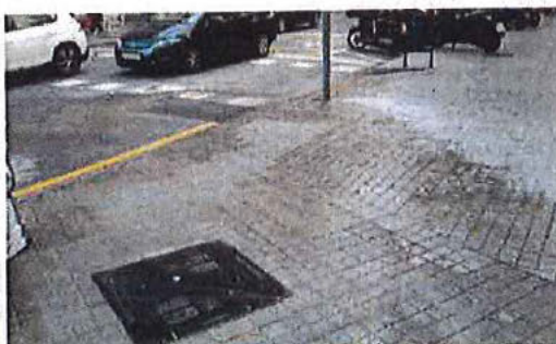
Imatge 10: Arqueta executada.
