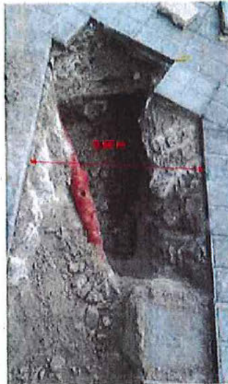
Imatge 3: Excavació de rasa
