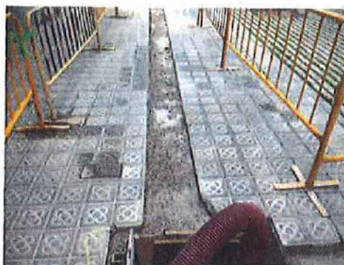
Imatge 6: Reblert complet de rasa, a falta de col·locació de panot.
