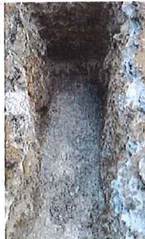
Imatge 5: Reblert de tubulars amb formigó
