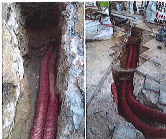
Imatge 4: Instal·lació de tubulars
