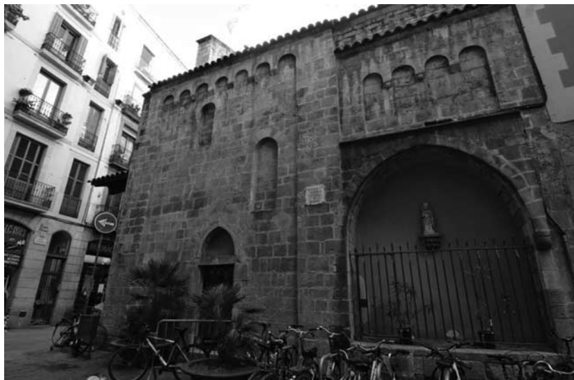
Façana lateral de la capella Marcús.
