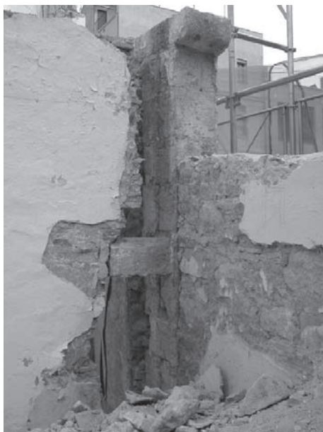
Un dels pilars de la porxada o solana descoberta a nivell de segon pis de façana (c. Carders, núm. 33).
