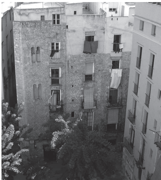
Façana principal de la finca núm. 14 del c. Correu Vell, amb finestres geminades, torre lateral i vestigis de porxada (paraments amb carreus).
