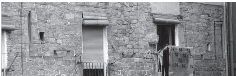
Detall del nivell de solana on encara hi podem distingir alguns dels pilars (c. Correu Vell, núm. 14).
