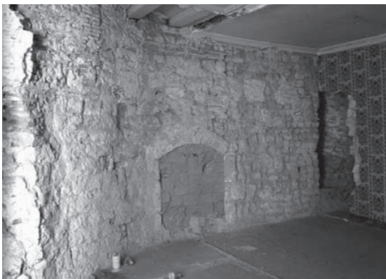
Murs corresponents a l'antic Castell Vell del Regomir (c. Regomir, núm.7-9), visibles als pisos superiors de la finca. Podem distingir l'estereotomia de tendència quadrangular dels carreus, característica lligada als temps de vigència del romànic.
