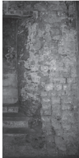
Murs corresponents a l'antic Castell Vell del Regomir (c. Regomir, núm.7-9), visibles als pisos superiors de la finca. Podem distingir l'estereotomia de tendència quadrangular dels carreus, característica lligada als temps de vigència del romànic.
