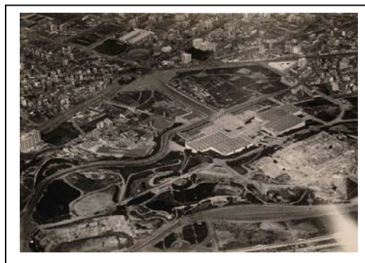
Inici de les obres de l'Exposició 1929
