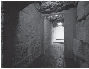
Fig. 22 Passadís excavat a la muralla del primer pis del carrer Avinyyó, 17-19. A l'esquerra de la imatge, parament extern augustal ( opus certum ); a la dreta, part posterior del parament de la muralla baiximperial ( opus quadratum ). (Foto: MUHBA)
