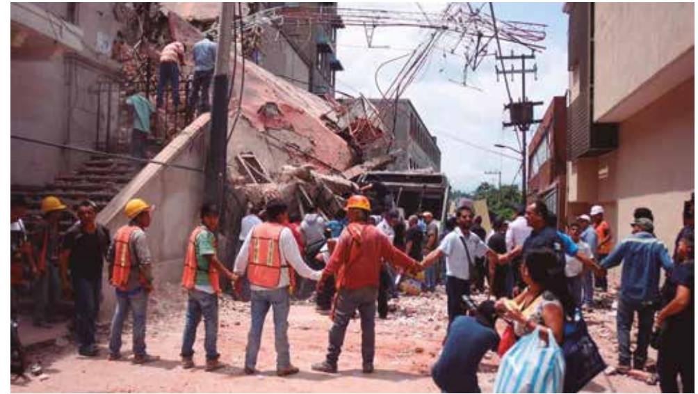
Dégâts causés au Mexique par le tremblement de terre de septembre 2017
