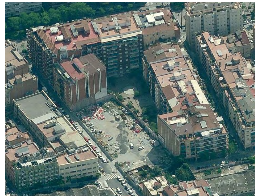
Vista de les cobertes de les edificacions dins l'àmbit i del pati de veïns interior de l'illa
